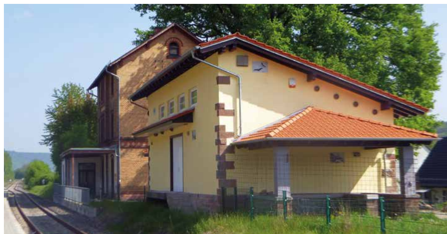
Abb. 3: Der Zustand im Mai 2019. An der Güterhallenfassade fehlen nur noch kleinere Restarbeiten wie die Verblendung der Türnischen mit Holz und die Beseitigung von Farbschmierereien auf den Sandsteinquadern. Dank des neuen Daches kommt nun die als Naturdenkmal geschützte Eiche neben dem Bahnhof auch aus dieser Perspektive besser zur Geltung. (Foto: S. Diehl)
