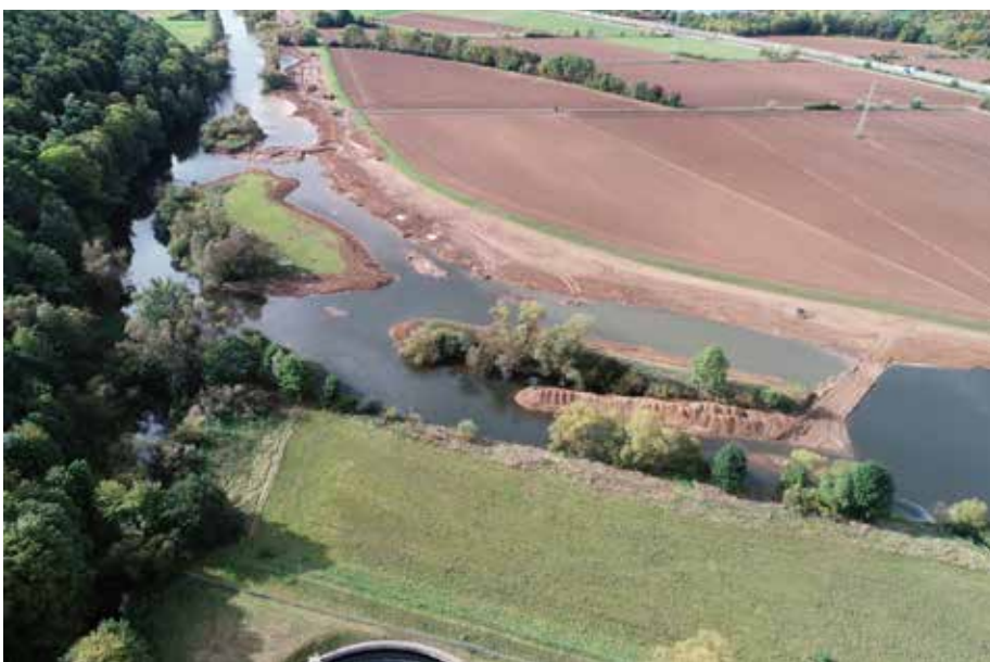
Abb. 4: Von der Baustelle zum Biotopverbund (Foto: Regierungspräsidium Gießen)
