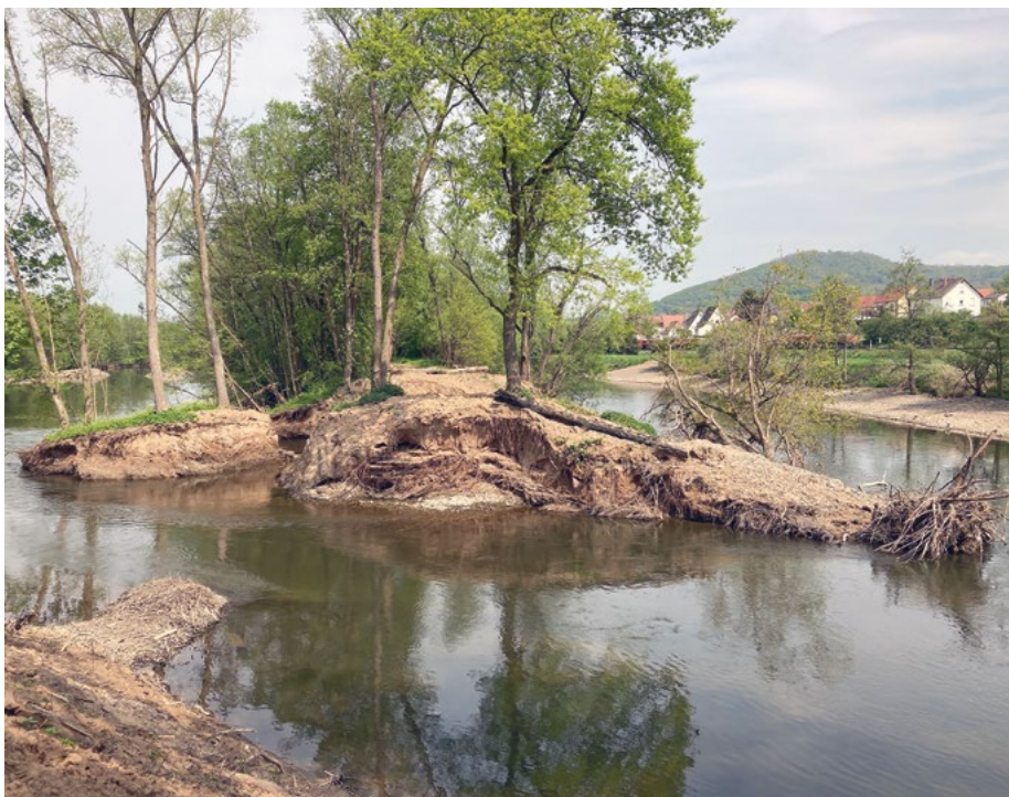
Abb. 3: Untere Eder mit Ansicht eines von vier Durchbrüchen durch den Damm zum sogenannten Schwanenteich. Bereits nach wenigen Wochen wird die eigendynamische Entwicklung der Eder sichtbar. (Foto: C. Henschke)
