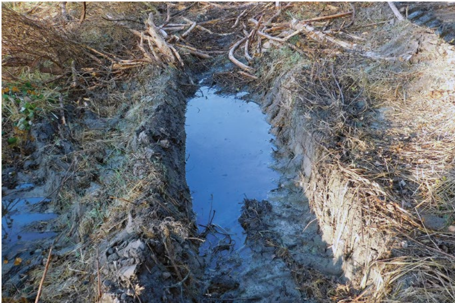
Abb. 2: Irreparable Bodenschäden durch Befahrung mit Holzerntemaschinen westlich des Parkplatzes „Roter Stock“ (Reinhardswald) – nach Auffassung der Unteren Naturschutzbehörde kein Eingriff und „gute fachliche Praxis“ (Foto: N. Panek)
