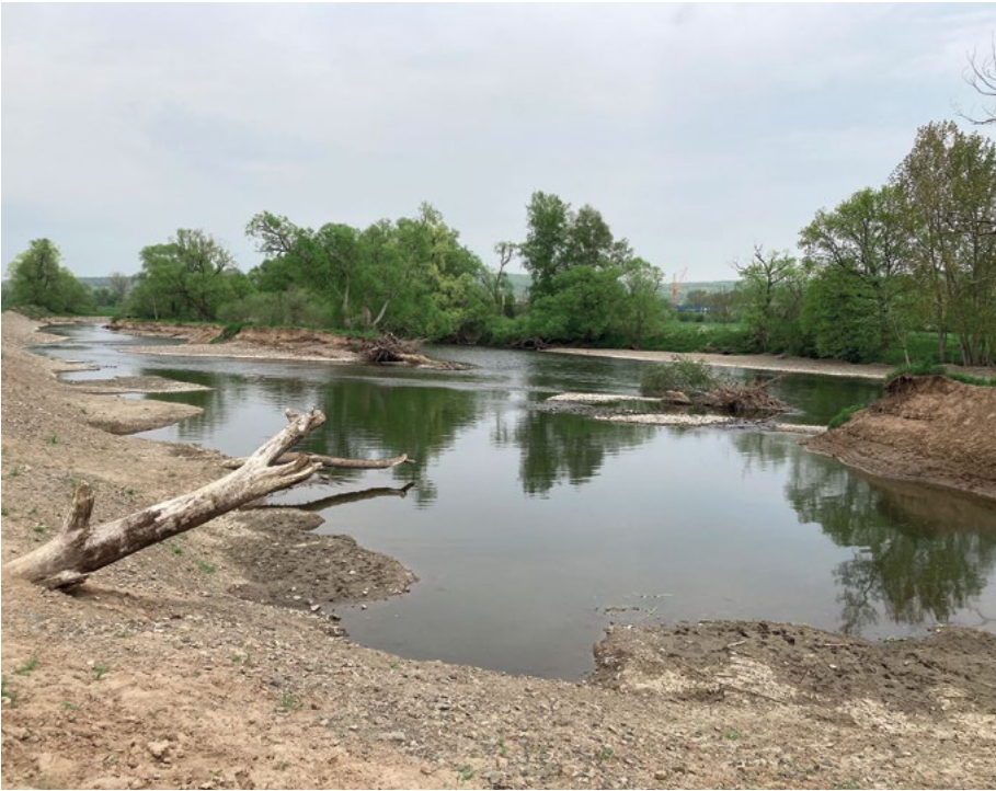
Abb. 2: Untere Eder bei Felsberg mit Darstellung der Gewässeraufweitung und -neustrukturierung. Im Hintergrund ist der alte Lauf zu sehen, am rechten Ufer eine darin neu angelegte Kiesbank. (Foto: C. Henschke)
