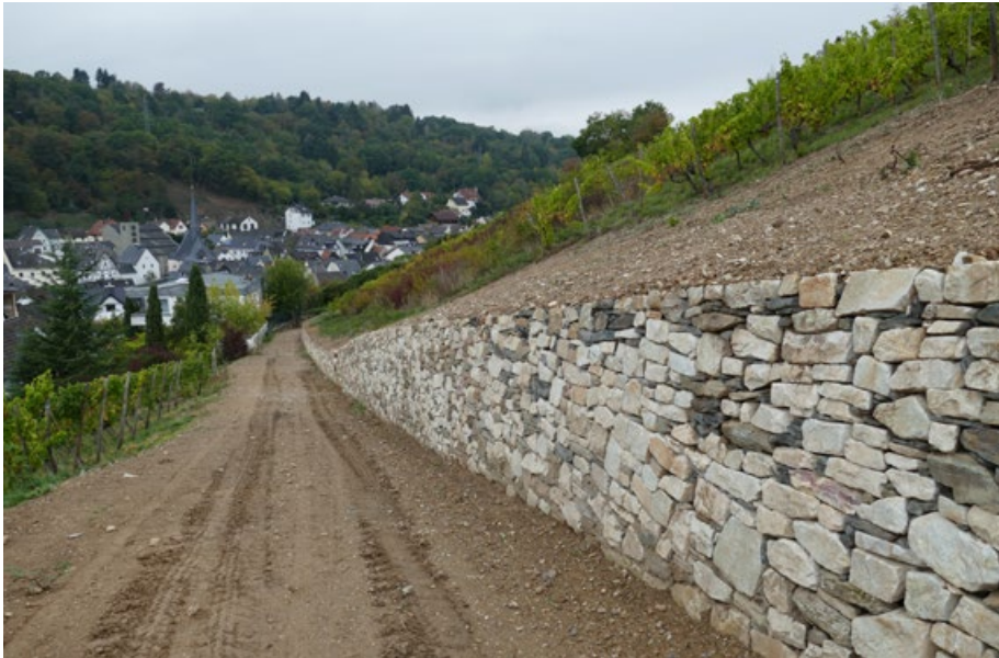
Abb. 3: Eltville-Martinsthal: Nach Abschluss der Trockenmauersanierung fügt sich die Mauer perfekt in das Gesamtbild ein. (Foto: LPV Rheingau-Taunus)
